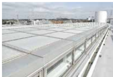
技術センター屋根部（トップライト）▶シルバーフィルムを施工
