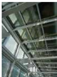
技術センター屋根部（トップライト）▶シルバーフィルムを施工
