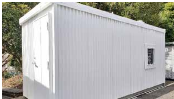
プレハブ倉庫 ▶塗料を施工
